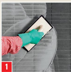
1 Mélanger le contenu du sac (5 kg) dans env. 1,4 l d'eau propre. Au bout de 5 min, bien mélanger à nouveau. Remplir les joints de la colle-mortier à l'aide d'un platoir en mousse en effectuant des mouvements en diagonale. Racler le surplus.
