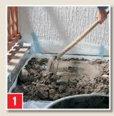
Herstellen eines Estrichs: Hier auf einem Balkon, mit unterlegter PE-Folie als Gleitschicht.
