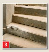
Reparatur einer schadhaften Betontreppe: Haftbrücke aus R & R-HOCH-LEISTUNGSMÖRTEL und BESSERER MÖRTEL aufbürsten. Frisch in frisch weiterarbeiten.
