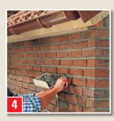
Ausfugen einer Ziegelwand: Erdfeucht angemischten Mörtel mit Fugeisen einbringen und nachglätten.
