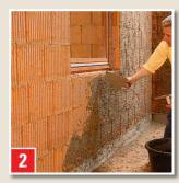
Herstellen eines Außenputzes auf einer Hohllochziegelwand: Spritzbewurf deckend aufbringen.
