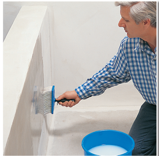
Grundieren eines saugfähigen Putzes vor Folgearbeiten, z. B. Anstreichen.
