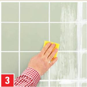
**3** Nach 1-stündiger Trocknung überschüssiges Material auf den Fliesen mit Reinigungsschwamm anfeuchten. Nach 5 Minuten abreiben.
