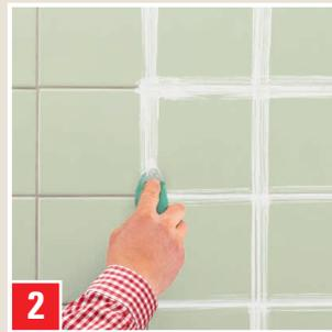
**2** Mit dem Schwamm entlang der Fugen auftragen. Bei Umfärbungen von dunkel auf hell in zwei Arbeitsgängen arbeiten.
