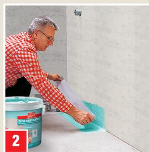
Alle Einbauteile (DICHTUNGSBAND, INNENECKEN, AUSSEN-ECKEN und an Rohrdurchführungen DICHTUNGSMANSCHETTE) im Stoßbereich 5 cm überlappen lassen und mit DUSCHABDICHTUNG fixieren.
