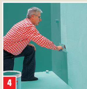
Die 2. Abdichtungslage wie vorher beschrieben auftragen. Achtung: Bei Abdichtungen nach DIN 18534-3, ist die 2. Abdichtungslage andersfarbig auszuführen, hierfür vorher beiliegenden FARBSATZ homogen in DA einmischen.
