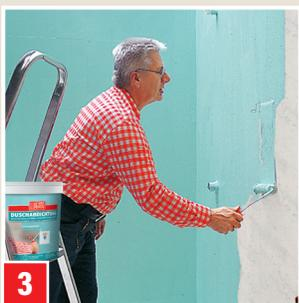
Erforderliche eingebaute LUGATO Systembauteile deckend überstreichen. 1. Schicht mindestens 5 Stunden trocknen lassen. Der Auftrag kann mit Rolle, Glätter oder Moosgummibrett erfolgen.
