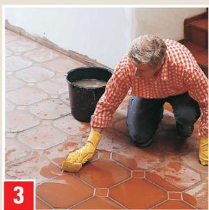
Fliesenoberfläche mit feuchtem Schwamm/Schwambrett reinigen. Schwamm nur in eine Richtung unter leichtem Druck über die Fläche ziehen.
