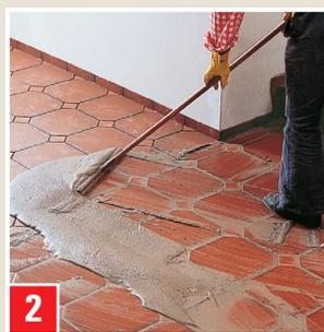
Fugenmörtel mit Gummischer diagonal in die Fugen einschlänmen. Überschüssiges Material abstreifen. Mörtel ansteifen lassen (Fingertest: es darf kein Mörtel am Finger haften bleiben).
