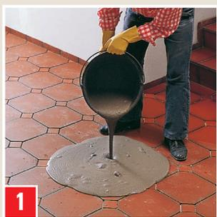
**Verwendung als Schlämfugenmörtel (Anwendung 1):** Sackinhalt (20 kg) mit langsam laufendem Rührwerk in ca. 4,0 l sauberes Wasser einrühren. Nach 5 Min. nochmals durchrühren. Ausgießen.
