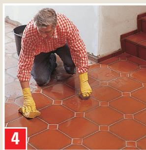
Schwamm mehrmals auswaschen und gut ausdrücken. Letzte Schleier nach einigen Stunden mit weichem Tuch oder am nächsten Tag mit angefeuchtetem Schwamm entfernen.
