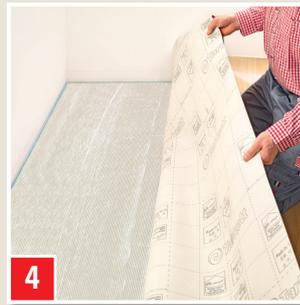
Den zurückgeschlagenen Belag nach der Ablüfzeit einlegen und mit einem passenden Werkzeug gut anreiben. Diesen Vorgang nun auch mit der anderen Hälfte wiederholen.
