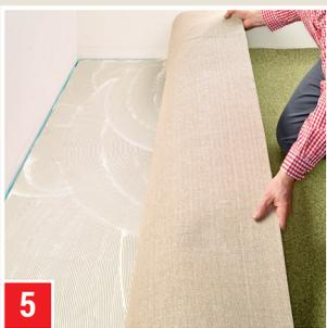
Den zurückgeschlagenen Teppich in das Klebstoffbett einlegen und mit einem geeigneten Werkzeug gut anreiben, besonders am Rand- und Nahtbereich. Diesen Vorgang nun auch mit der anderen Hälfte wiederholen.
