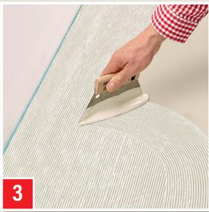
Vor Gebrauch gut aufrühren. DESIGN- & PVC-BELAGSKLEBSTOFF mit geeigneter Zahnung gleichmäßig auf dem Untergrund verteilen. Klebstoffnester vermeiden.
