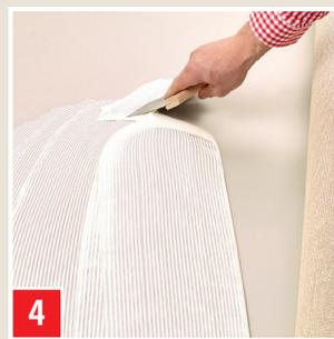
...und mit der passenden Spachtelzahnung gleichmäßig auf dem Untergrund verteilen. Klebstoffnester vermeiden.
