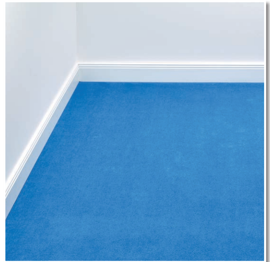
Moquette fixée en plein, tient en place comme avec de la colle.
