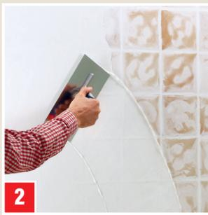
**Überspachteln eines alten Fliesenbelages:** Zunächst oberflächenbündig bis zur Füllung der Fugen aufziehen und trocknen lassen. Danach FEINER FLÄCHENSPACHTEL in gewünschter Schichtdicke auftragen.
