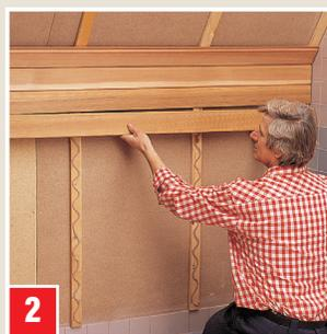
Klebgut innerhalb von 15 Minuten andrücken und ausrichten. Spannungsreiche oder schwere Klebgüter ca. 24 Stunden abstützen. Frische Klebstoffreste feucht abwischen.
