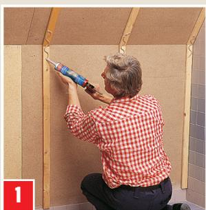
Klebstoff mit Auspresspistole auf Untergrund oder Klebgut streifenförmig auftragen.
