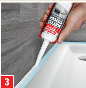
3 Appliquer MATTES SILICON dans le joint avec le pistolet applicateur.
