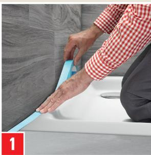
1 Avant l'étanchéification élastique, coller du ruban adhésif au niveau des bords des joints.
