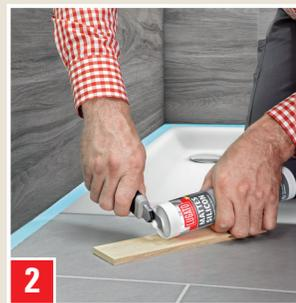
2 Couper la pointe de la buse en biais (en fonction de la largeur du joint) et la pointe de la cartouche.
