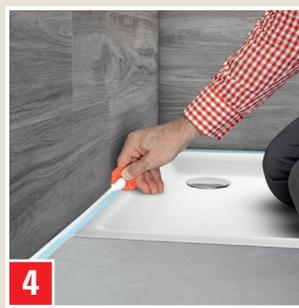
4 Entro 15 minuti spianare con FUGENGLÄTTER (inumidito con SILICONGLÄTTMITTEL). Il grado massimo di opacità si raggiunge con una sola stesura. Staccare subito il nastro adesivo, event. lisciare i bordi delle fughe.
