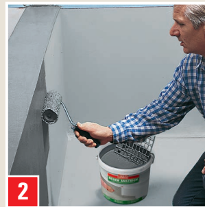
Abriebfeste Versiegelung einer Betontreppe: NEUER ANSTRICH im Farbton platingrau.
