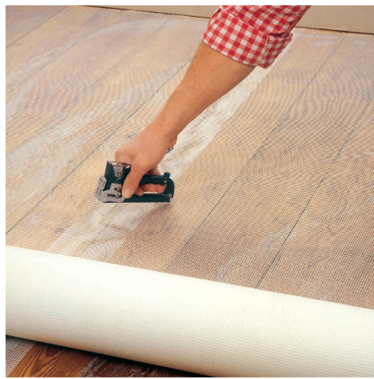
L'armature avant le ragréage avec NEU AUF ALT!.
