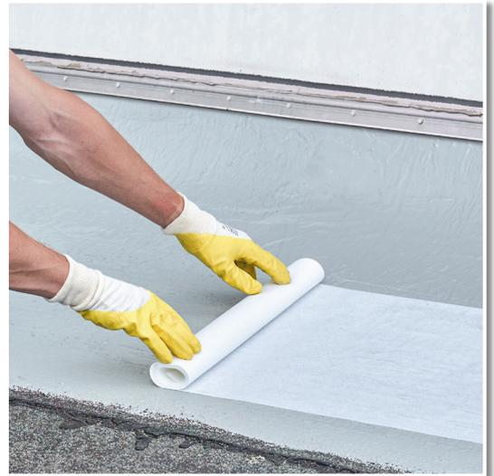
ABDICHTUNGS-VLIES zur norm-konformen Abdichtung mit PROTEKT Flüssigkunststoffen.
