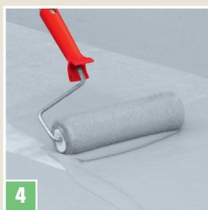
**4** Deckauftrag frisch in frisch vor Hautbildung gleichmäßig dick, auf Vlies auftragen. Die Vliesstruktur muss vollständig abgedeckt sein.
