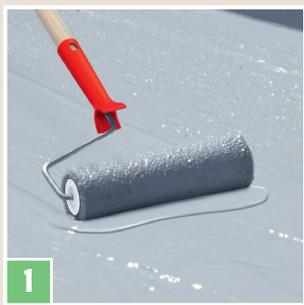
**1** Basisauftrag PROTEKT Flüssigkunststoff flächig in erforderlicher Menge vorlegen.
