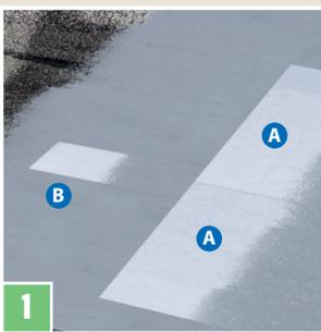
MULTIFUNKTIONS-ABDICHTUNG 1K PRO oder DACHABDICHTUNG 1K mit Pinsel oder Rolle aufstreichen. Im Stoßbereich des ABDICHTUNGS-VLIES 30, 50, 100 (B) auf das STOSSFUGENBAND (A) mittig und faltenfrei in den frischen Auftrag einlegen. STOSSFUGENBAND mit mind. 1 kg/m<sup>2</sup> Flüssigkunststoff überstreichen. Vlieskante des ABDICHTUNGS-VLIES 30, 50, 100 Stoß an Stoß über das STOSSFUGENBAND einlegen.
