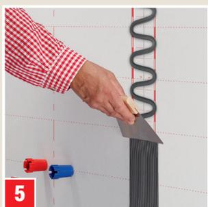
**5** Pour coller des éléments de montage du système sur ABDICHTUNGSBAHN (fig. 5-7) : injecter BOMBENFEST et appliquer sur une largeur de 12 cm au milieu de la zone de joints à l'aide d'une spatule dentée.
