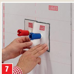
**7** Insérer les éléments de montage du système (ici DICHTUNGSMANSCHETTE) dans la colle BOMBENFEST appliquée et lisser.
