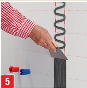
**5** Zum Kleben von Systemeinteilen auf ABDICHTUNGSBAHN (Abb. 5–7): BOMBENFEST auspritzen und mittels Zahnpachtel mittig über dem Stoßbereich 12 cm breit auftragen.
