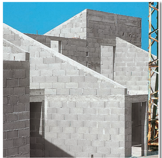
Wohnsiedlung. Vorbereiten von Planblockmauerwerk für Dekorputze mit ROHBAUSPACHTEL AUSSEN.
