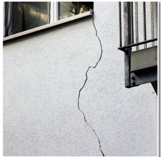
Typisches Objekt für den Rissverschluss mit RISS-STOPP WAND + FASSADE.
