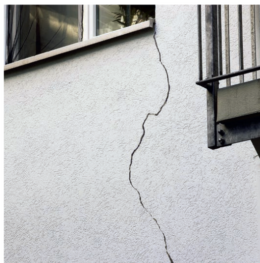
Situation typique de colmatage de fissures avec RISS-STOPP WAND + FASSADE.
