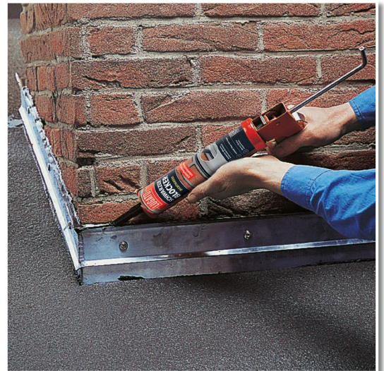
Abdichten einer Kappeleiste am Schornstein mit SCHWARZER BLOCKER DICHTMASSE.
