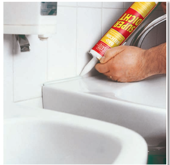
Fuge am Waschbecken dauerelastisch abdichten.
