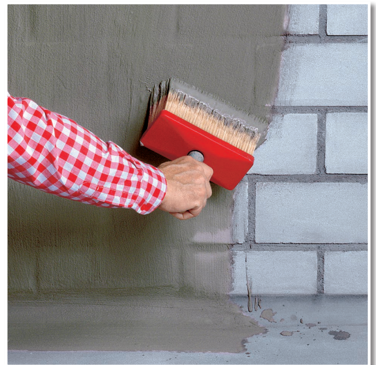
Abdichten mit TROCK'NER KELLER DICHTUNGSSCHLÄMME, hier auf Kalksandsteinmauerwerk.
