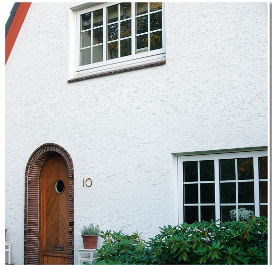
Hausfassade geschützt und verschönert mit WEISSES HAUS REIBEPUTZ AUSSEN.
